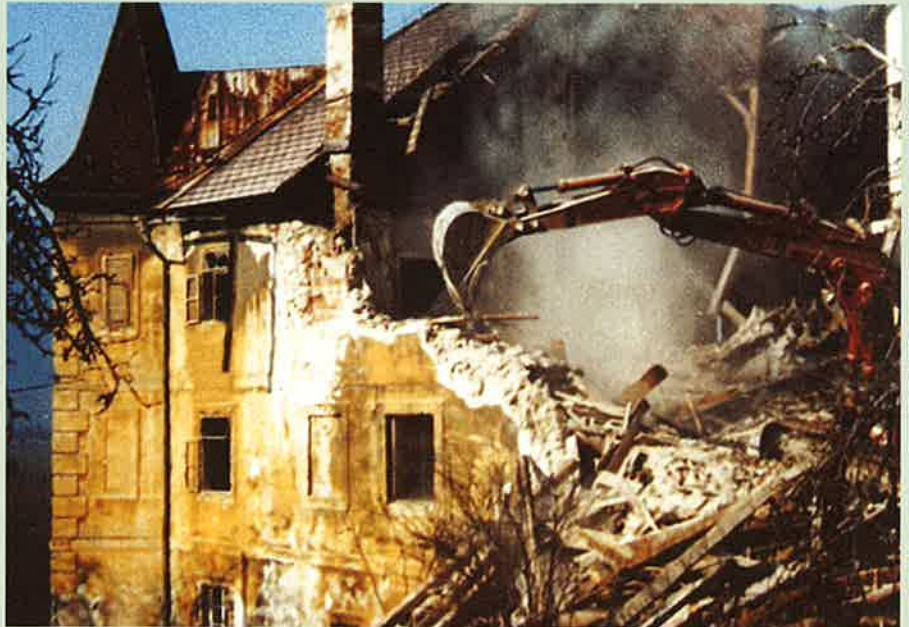
Abbruch des Gebäudes am 17.4.1982
