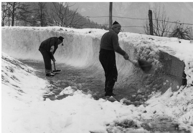
Ausbau mit Schneematsch
