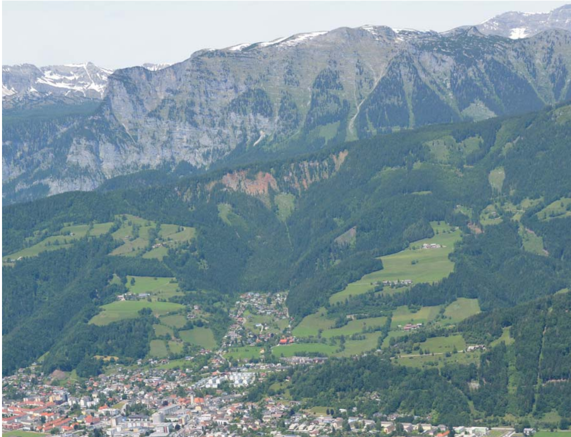
Ansicht von Süden (Rote Wand in Bildmitte)
