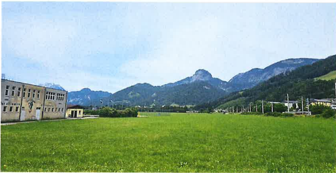
Abb. 13; Ansicht von Osten, 2024
