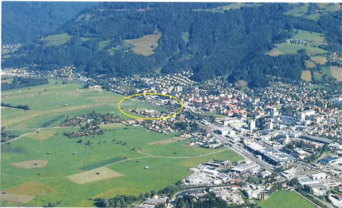
Abb. 11; Ansicht von Südosten, 2017
