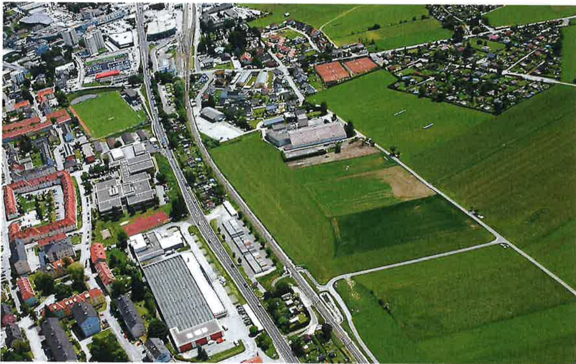
Abb. 3: Ansicht von Nordwesten, 2017
