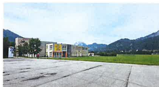
Abb. 16; Ansicht von Nordosten, 2024 (Sporthallenkomplex)
