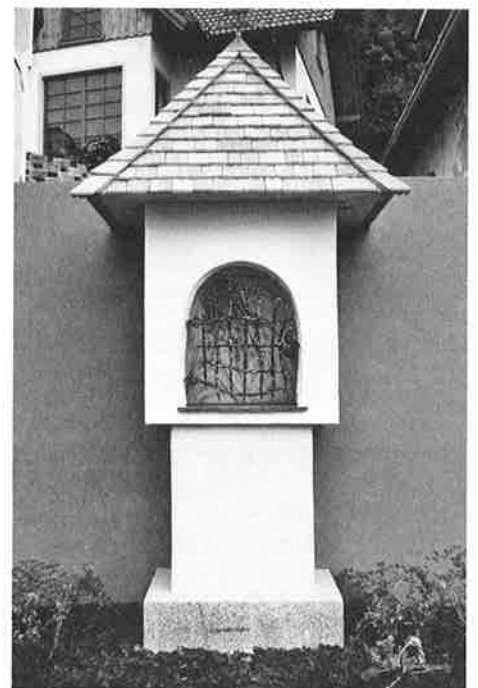
Der zweite vom Bauhof der Stadtgemeinde fachkundig errichtete Bildstock.
