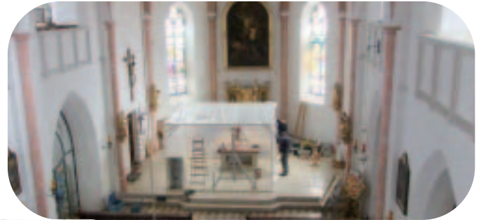
eine Einhausung soll den ärgsten Staub verhindern.
