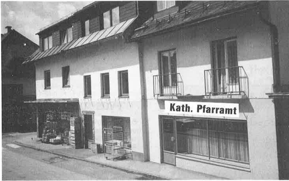
Das kath. Pfarramt in Gesamtansicht mit dem Gebäude Rohrauer
