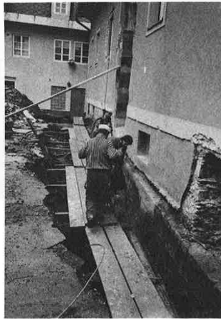
Die Bilder geben einen Einblick in die sehr kostenintensiven Sanierungsarbeiten an der Bausubstanz, innen und außen; Fundamente mußten eingezogen oder ergänzt werden, die Wassereinträge in den Kellerräumen unter Kontrolle gebracht werden.
