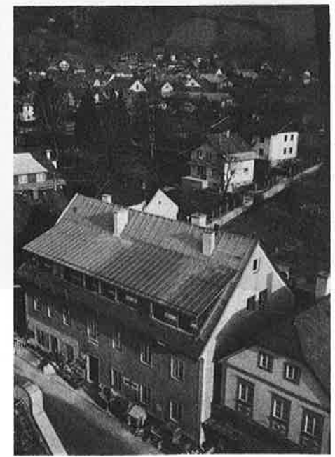
Der Pfarrhof bekam straßen- und hofseitig ein Kaldach, damit die Gefährdung der Passanten durch herabstürzende Schnee- und Eisbrocken aufhört.
