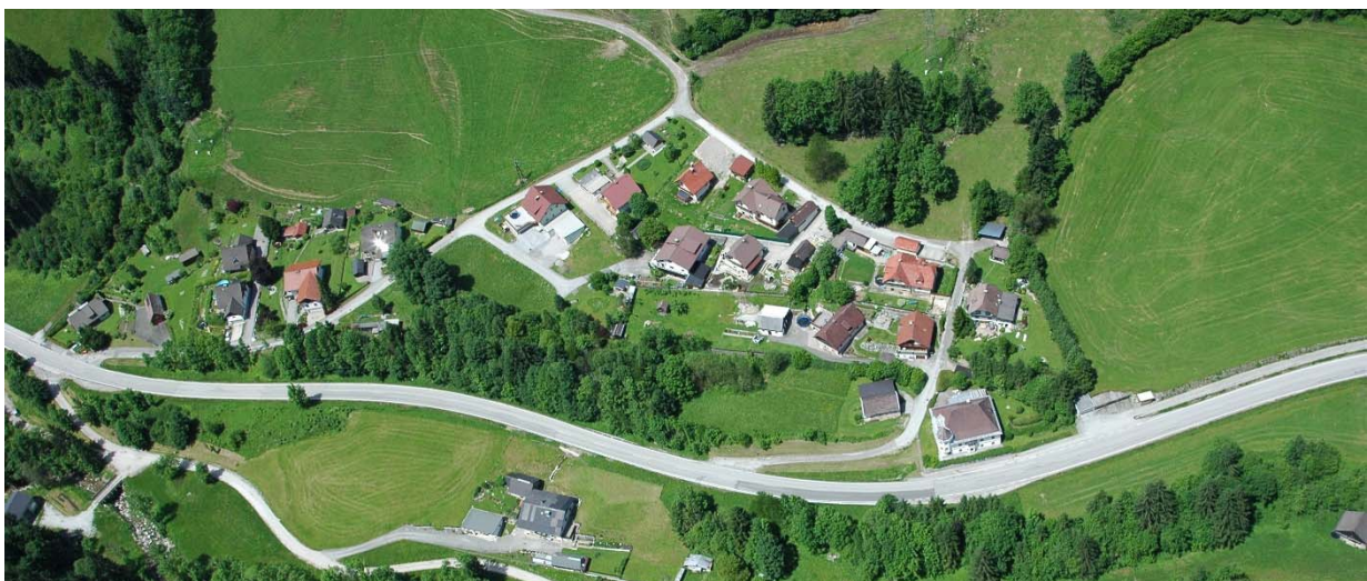
Ansicht von Osten, 2017
