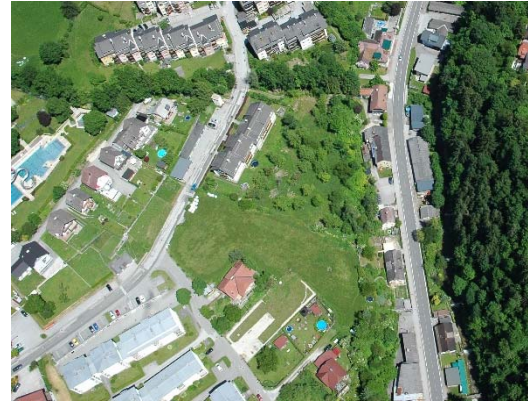
Ansicht von Süden, 2017 / A(33)
