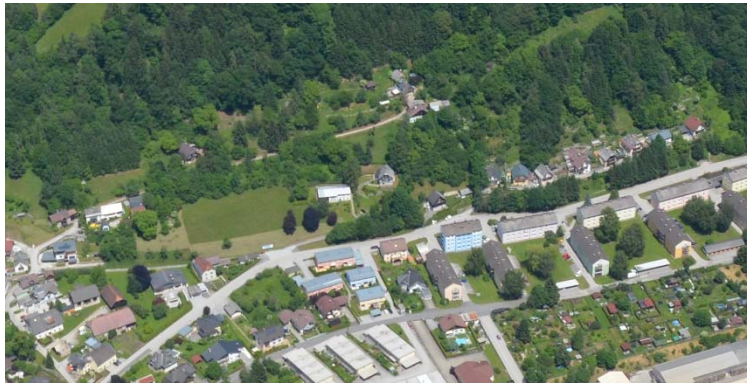
Ansicht von Süden, 2017 / Reithtal West
