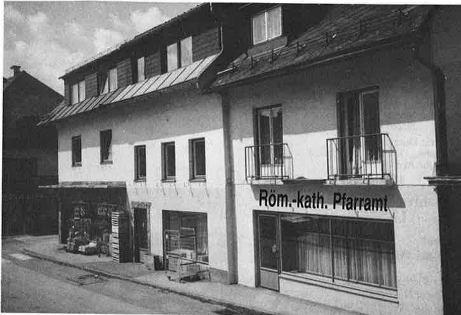
Das Kath. Pfarramt ab 29. Jänner 1990 im Objekt Rohrauer, Salzstr. 1
