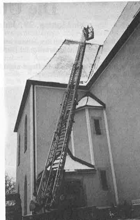
Die Stadtfeuerwehr half bei der Behebung von Sturmschäden des Sommers 1989.
