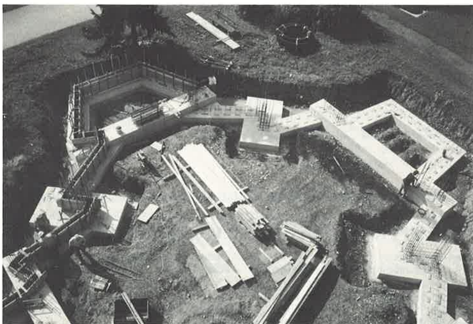
Die Fundamente der Verabschiedungshalle – vom Kran aus gesehen. Die Spendenaktion der Pfarre zugunsten der sakralen und künstlerischen Ausstattung hat begonnen. (Lesen Sie auf Seite 3) Foto: Urbscheit Fred
