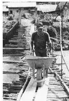
Sand, Zement ... alles muss vom Dorf, von der Straße so über diese Brücke zum Sportplatz gebracht werden.
