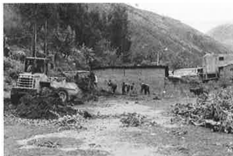
Baubeginn Ende Jänner
