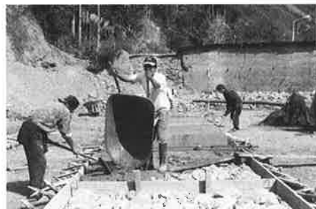
Die einzelnen Betonfelder entstehen.
