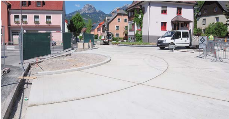
Die Fahrbahn des Kreisverkehrs wurde in zwei Etappen betoniert.
