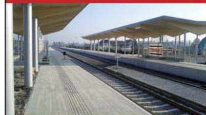
Im Bereich der Haltestellen wurden erstmals eigene Blindenleitsysteme eingebaut.
