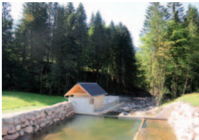
Das Einlaufbauwerk bei der Marchtalbrücke.
