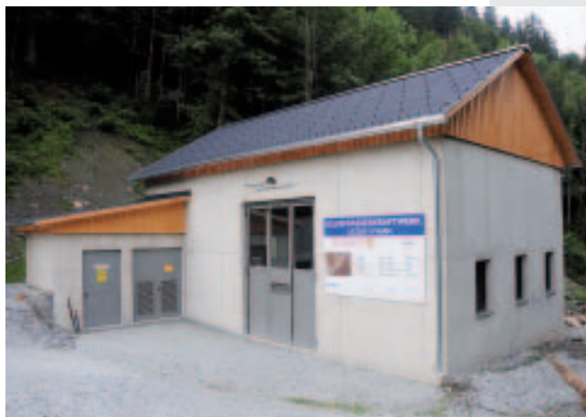
Im Kraftwerkshaus befindet sich die Turbinenhalle.
