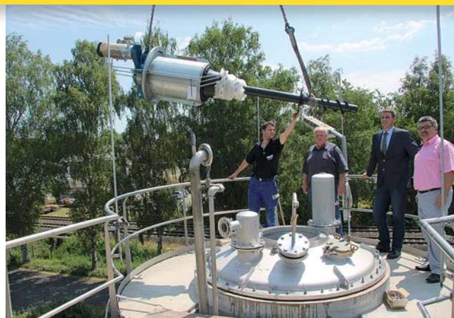
Das Foto zeigt das Einlassen des neuen Mischers in den Faulbehälter. Weiters im Bild sind (v. l.): Christian Schneider von der ausführenden Firma, Gerhard Scheer vom Planungsbüro, Bürgermeister Frank Inderthal und der Leiter der Stadtwerke, Wilfried Klabunde.
