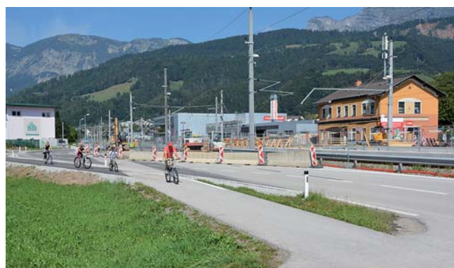
Mit dem Bau der Unterführung der Gleisanlagen wurde bereits begonnen. Die Schönaustraße samt Rad- und Fußweg wurde hierfür verlegt.
