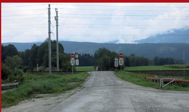
Der gefährliche Eisenbahnübergang beim Autohaus Pfleger wird geschlossen und durch einen Fußgängertunnel ersetzt.
