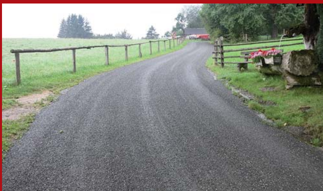
Belagsanierung an der Höhenstraße.
