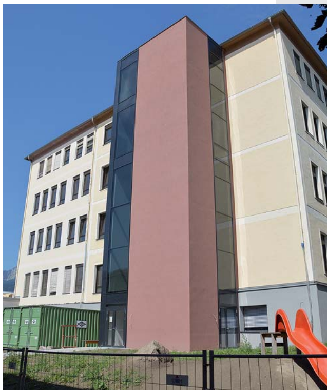
Die über mehrere Abschnitte angesetzte Generalsanierung und Modernisierung der Volksschule- und Sonderschule stellt insbesondere in finanzieller Hinsicht ein Großbauvorhaben dar. Hier im Bild der südseitige Zubau für das zusätzlich erforderliche Fluchtstiegenhaus und den Personenaufzug zur Barrierefreiheit.
