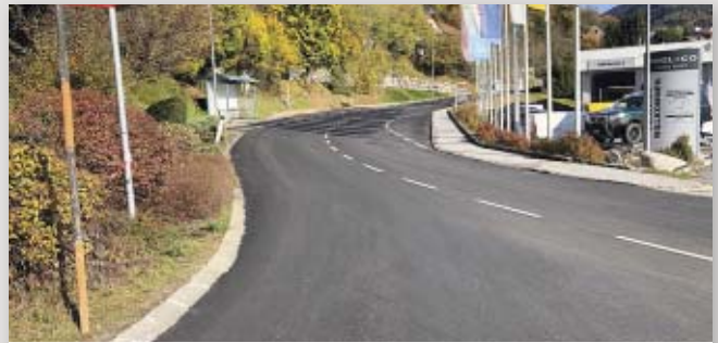
Die frisch asphaltierte Ausseer Straße im Bereich West Ein- und Ausfahrt.
