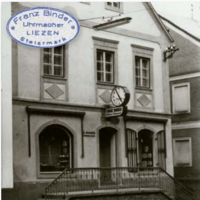
Die Gebäudefront um 1953.
