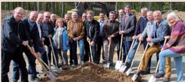
Zum symbolischen ersten Spatenstich für den neuen Hochbehälter am Galgenberg trafen sich alle Beteiligten und griffen dabei kräftig zur Schaufel.
