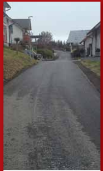
Der neu asphaltierte Schalenweg im Ortsteil Weißenbach.
