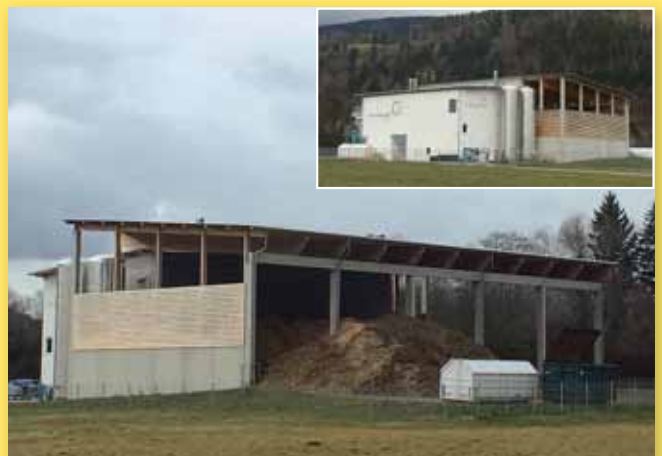
Ein Großteil der Aufgrabungsarbeiten für das innerstädtische Nahwärmenetz ist abgeschlossen. Jährlich werden ab nun ca. 2.200 Tonnen an CO 2 eingespart.
