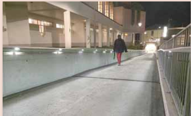
Die Handläufe mit LED-Beleuchtung gewährleisten nicht nur eine ausreichende Beleuchtung sondern auch die Barrierefreiheit und zusätzlichen Halt.
