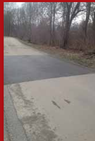
Die sanierte Fahrbahn am Manfred-Winkler-Weg in Richtung Lassing.
