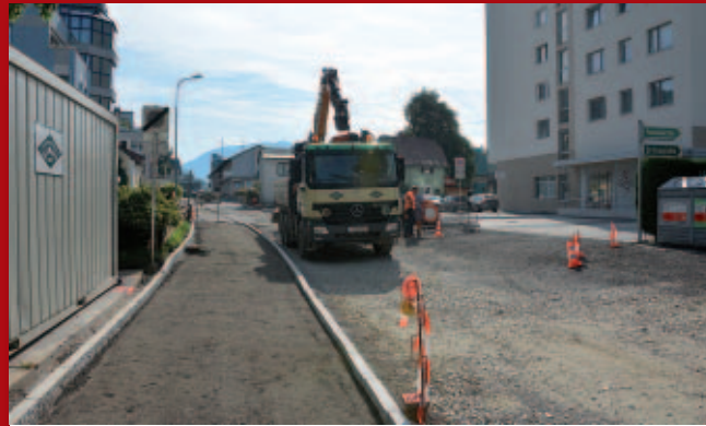
Mit Bauphase 2 wurde der längste Abschnitt der Sanierung eingeleitet. Dieser reicht bis zu Einfahrt Richtung Billa Parkplatz.
