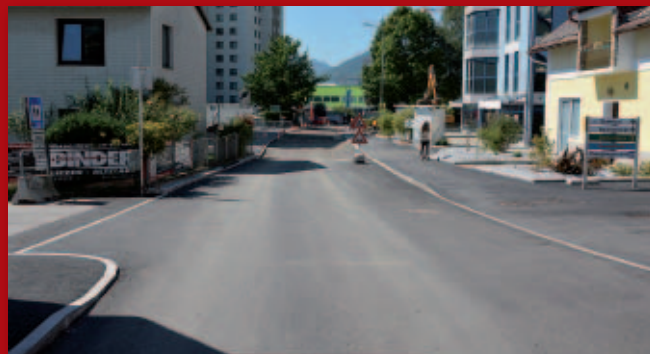
Gut am Bild ersichtlich die künstliche Fahrbahnverengung. Der Straßenquerschnitt ist nun auf die zur Verkehrsberuhigung verordneten 30 km/h ausgelegt.
