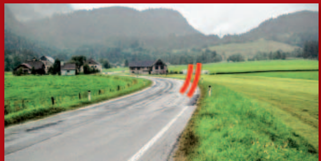
Die sehr unfallträchtige Straßenstelle, welche das Gehöft durchschneidet, wird komplett nach Osten verlegt – eine Zufahrt zur Gemeindestraße wird nördlich der Gebäude gebaut. Eine Gesamtsanierung der LB 138 wird ebenfalls 2018 umgesetzt.
