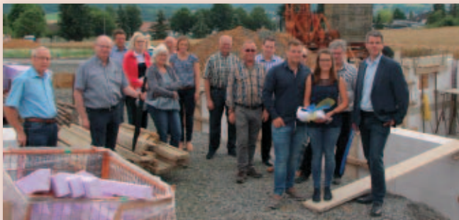
Bürgermeister Inderthal (r.) und der Magistrat besuchen die Bauherren Anna und Kevin Koch auf ihrer Baustelle.
