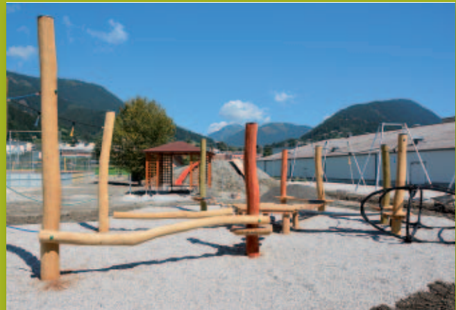
An der Fertigstellung wird mit Hochdruck gearbeitet.
