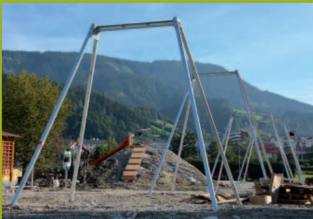
Hier ist die fast fertige Kletterstrecke zu sehen.
