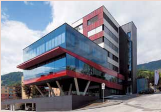
Das neu aus- und umgebaute Verwaltungsgebäude der Siedlungsgenossenschaft Ennstal, einer wichtigen Partnerin für den dynamischen Fortschritt der Liezener Stadtentwicklung.
