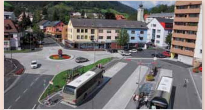
Ist wohl heute nicht mehr wegzudenken: Der Kreisverkehr mit dem Autobusbahnhof an der so genannten Wutscher-Kreuzung.
