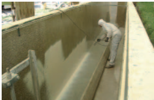
Nach erfolgter Betonsanierung wurde eine spezielle Beschichtung aufgebracht.
