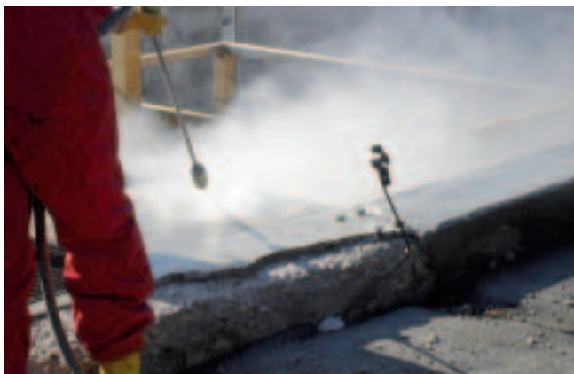
Altersbedingte Schäden wurden saniert.
