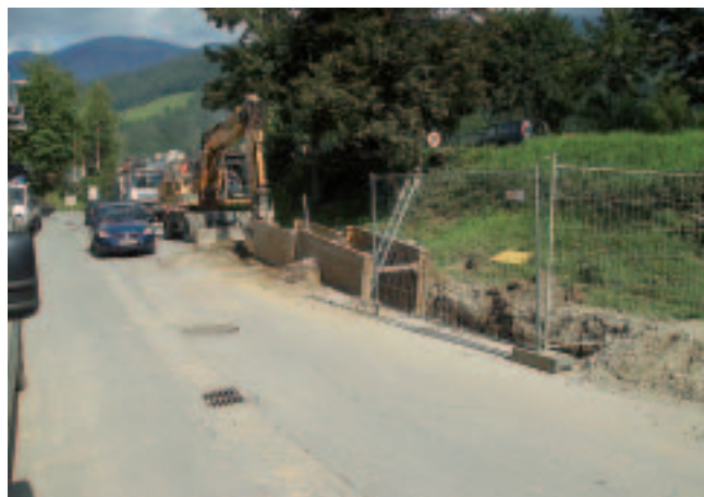
Die Sanierung des Hauptkanals südlich der Ennstal Bundesstraße musste vorgezogen werden.
