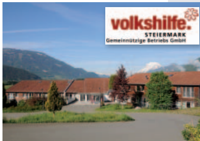
Das ehemalige Pflegezentrum am Sonnenweg wird zum „Generationenhaus Liezen“.
