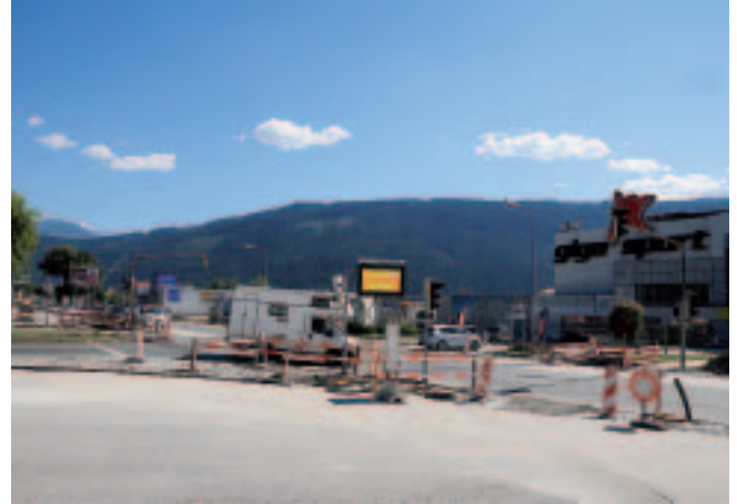
Die Arbeiten für die Sanierung und den Umbau der B320 Ennstalstraße liegen voll im Plan.
