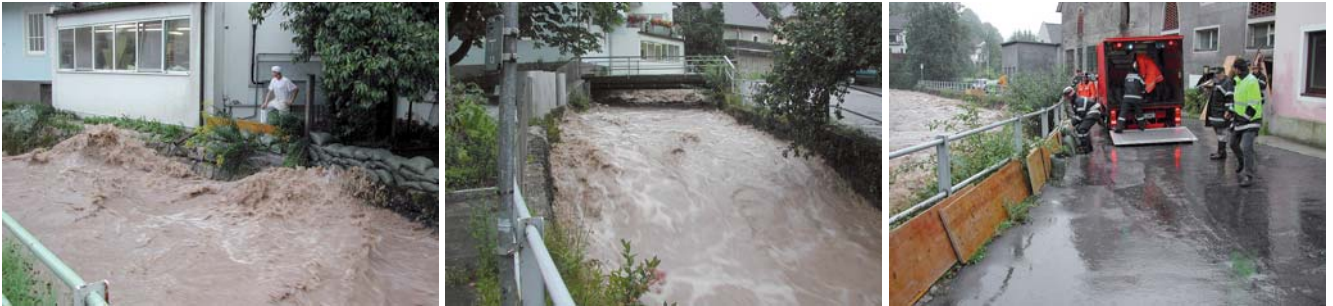
Gefahren durch den Pyhrnbach: Bereits im Jahr 2002 ging Liezen im Bereich Rainstrom/Bachzeile knapp an einer Katastrophe vorbei. Bei der Bäckerei Steindl erreichte der Wasserstand eine beängstigende Höhe.
