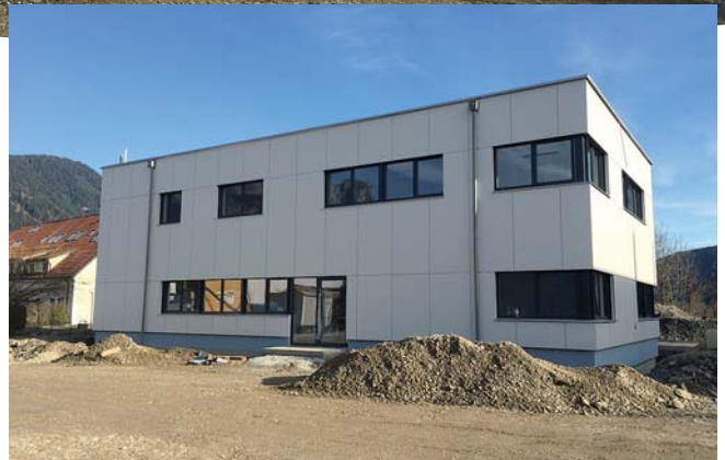
Das Verwaltungsgebäude mit Büros sowie den Sozial- und Sanitärräumlichkeiten.
