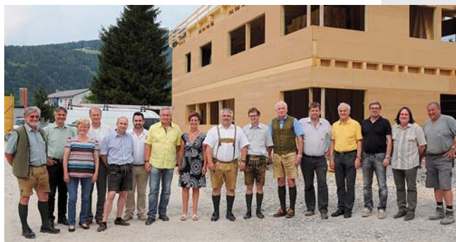
Die Vertreter der Stadtgemeinde Liezen, der Siedlungsgenossenschaft Ennstal, der Planungsfirma sowie der bauausführenden Firma bei der Gleichenfeier.
