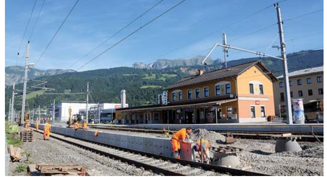
Die Arbeiten für die Verlängerung des Mittelbahnsteiges haben bereits begonnen.
