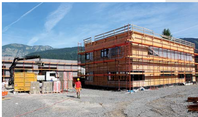
Die Hallen sind bereits im Rohbau fertiggestellt. Derzeit werden die Wärmedämmungen angebracht. Foto rechts: In diesem Gebäude werden die Büros ihren Platz finden.
