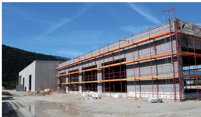
Die Hallen sind bereits im Rohbau fertiggestellt. Derzeit werden die Wärmedämmungen angebracht. Foto rechts: In diesem Gebäude werden die Büros ihren Platz finden.
