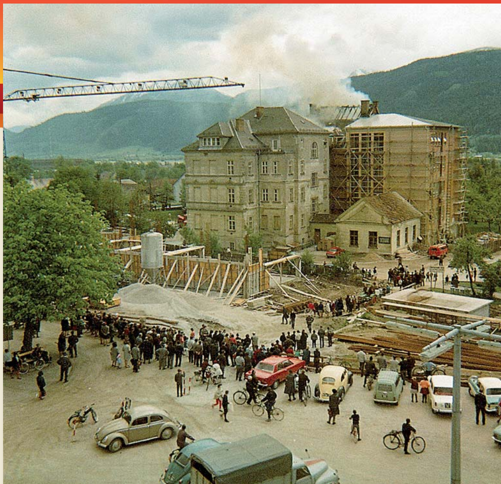
Einen weiteren großen Zubau gab es 1967 an der Westseite. Der Dachstuhlbrand (im Bild) störte den Ausbau nur wenig. Die Südseite des Hauptplatzes war damals noch nicht verbaut. Foto: Sammlung Kröllner
