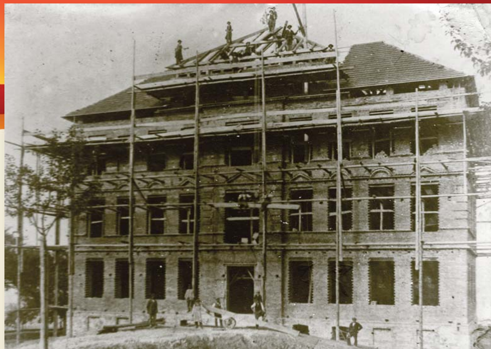
Die neue Volksschule war 1904/05 ein für Liezen großer Bau mit einer heute kaum mehr vorstellbaren Bautechnik.
