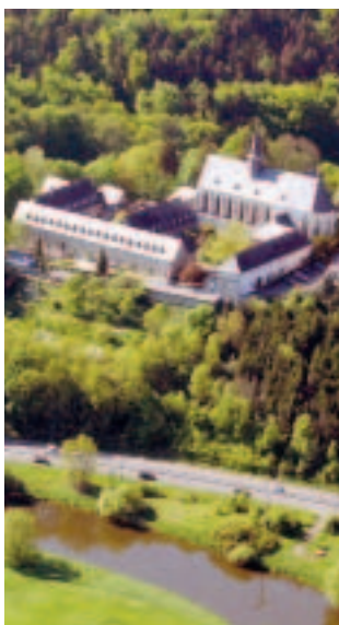
Die Klosterkirche wurde im 13. Jahrhundert erbaut.
